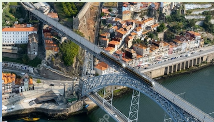
Puente Don Luis I - Oporto
